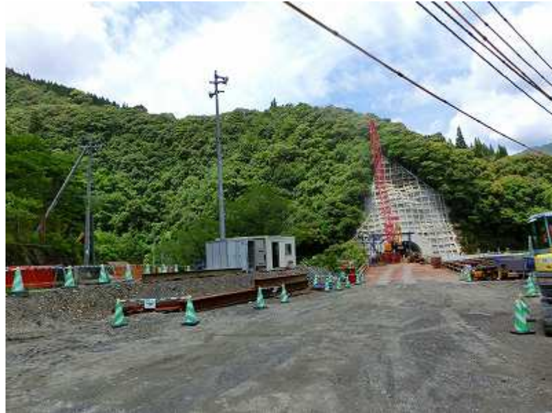
[ ↑小春工区の第1トンネル ]
