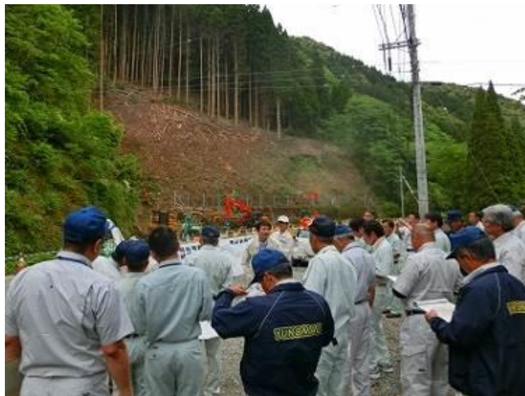
[ ↑ 小春工区の第2トンネル予定地 ]
