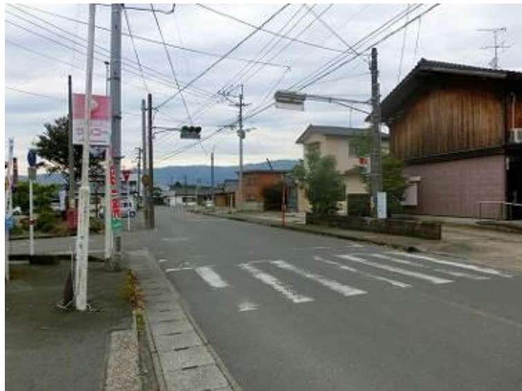
[ ↑ 湯前上里歩道整備（右側歩道） ]
