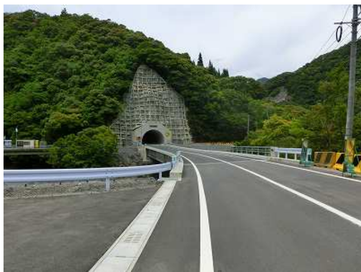
[ ←小春工区の第1トンネルと1号橋が完成 ]
