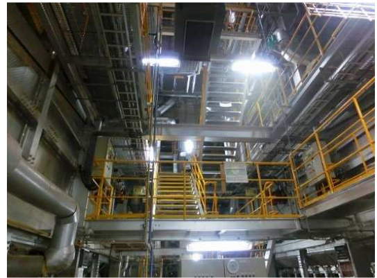
[クリーンプラザ焼却炉]
