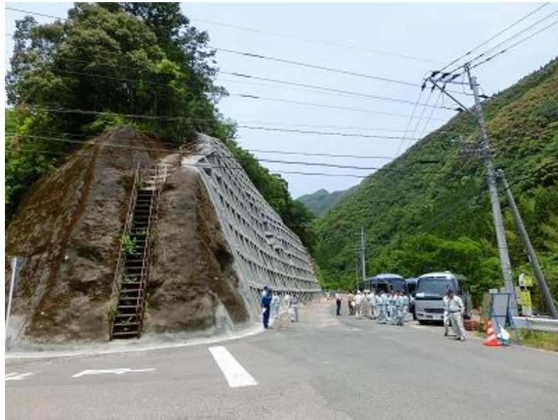
[ ↑ 桐原工区の現地調査 ]
